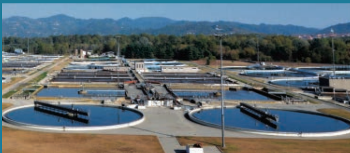
Uno dei moduli della linea acque dell'impianto di Castiglione T.se
